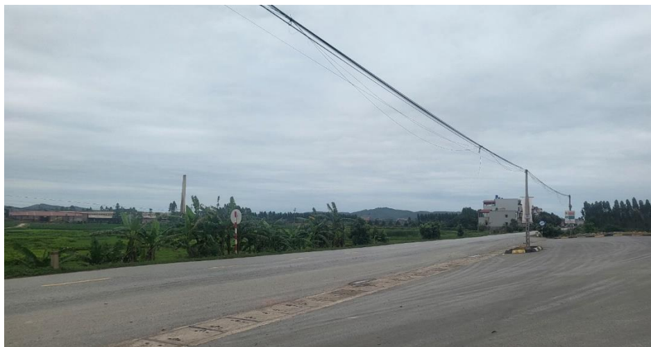
Hình 1. 3. Đường giao thông QL37
