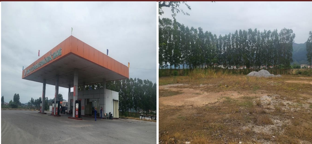
Hình 1. 2. Hiện trạng dự án
