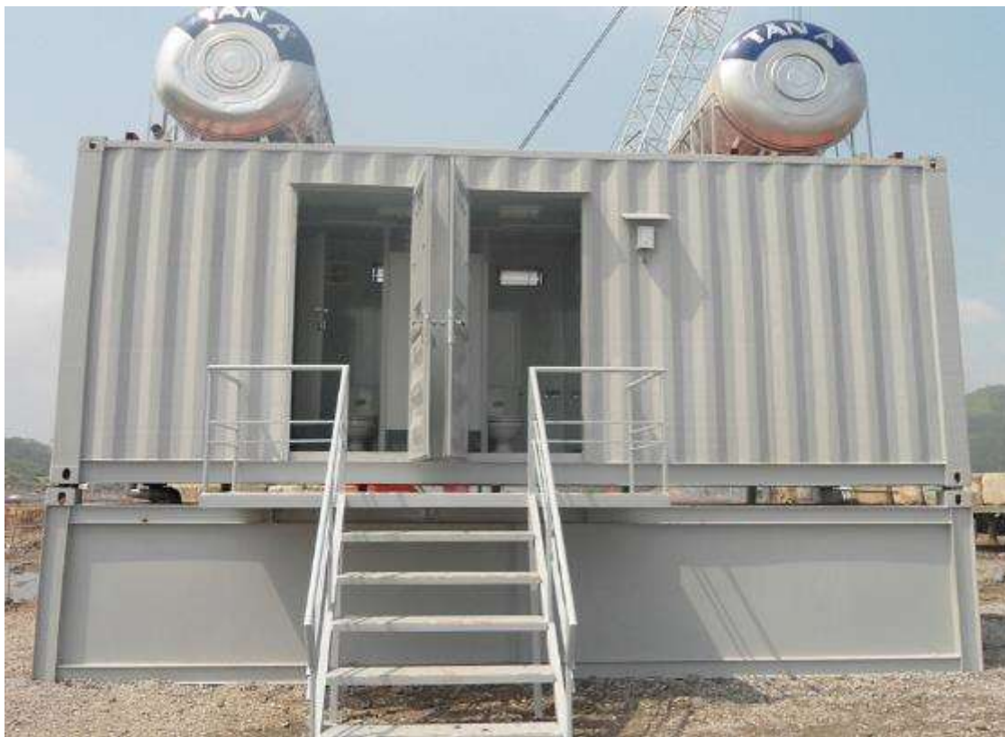
Hình 6. Hình ảnh minh họa container vệ sinh di động hợp khối
